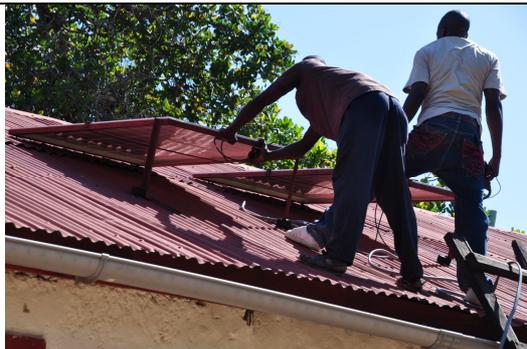
Befestigung der beiden 200-Watt-Solarmodule auf dem Dach des Computergebäudes
