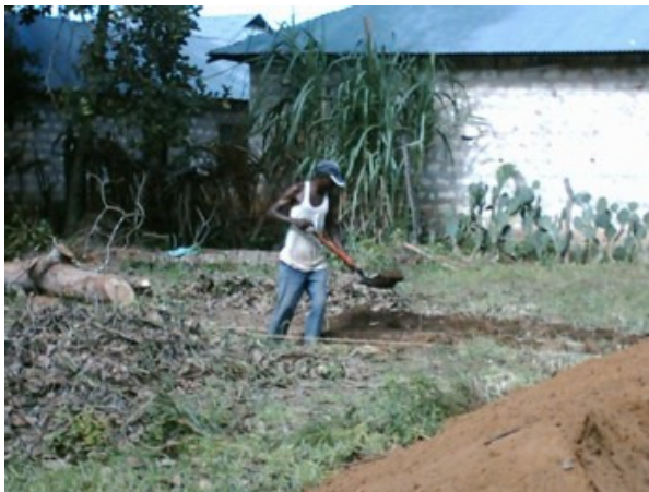
Bauarbeiter bei Fundament-Arbeiten.
