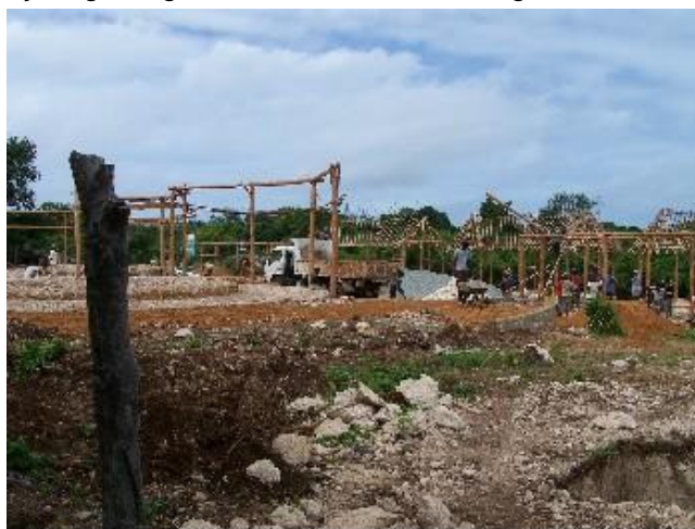
Auf dieser Baustelle sollen unser Bücherladen sowie unsere Kantine entstehen.
