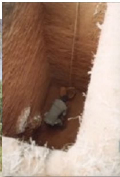
Ausschachtung für die Sanitäreinrichtungen
